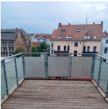
Wohnung 3.OG links - Terrasse
