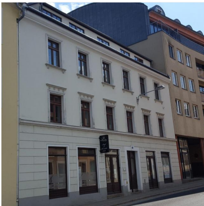
Außenansicht straßenseitig (Bild 2)
