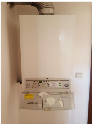
Gasetagenheizung
