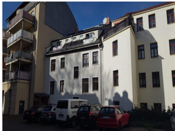
Außenansicht hofseitig (Bild 1)
