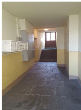
Treppenhaus / Hauseingangsbereich (Bild 1)
