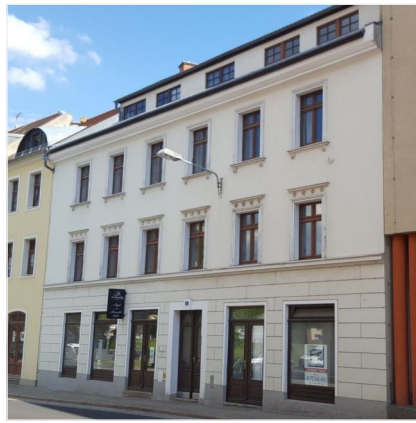
Außenansicht straßenseitig (Bild 1)
