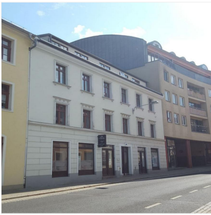
Außenansicht straßenseitig (Bild 3)
