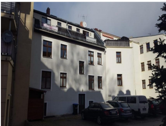
Außenansicht hofseitig (Bild 2)
